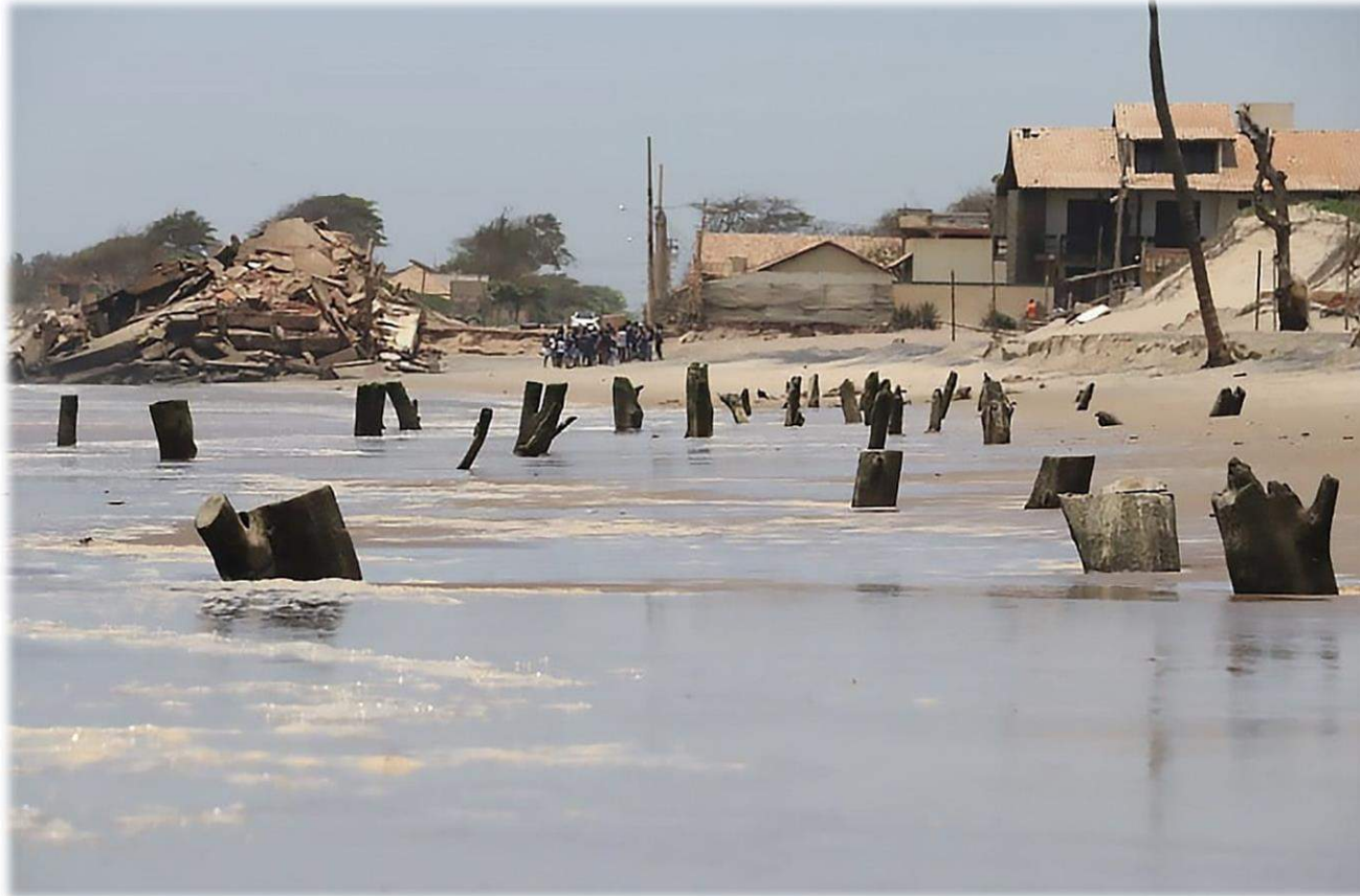
Avanço do mar no distrito de Atafona, São João da Barra - RJ
